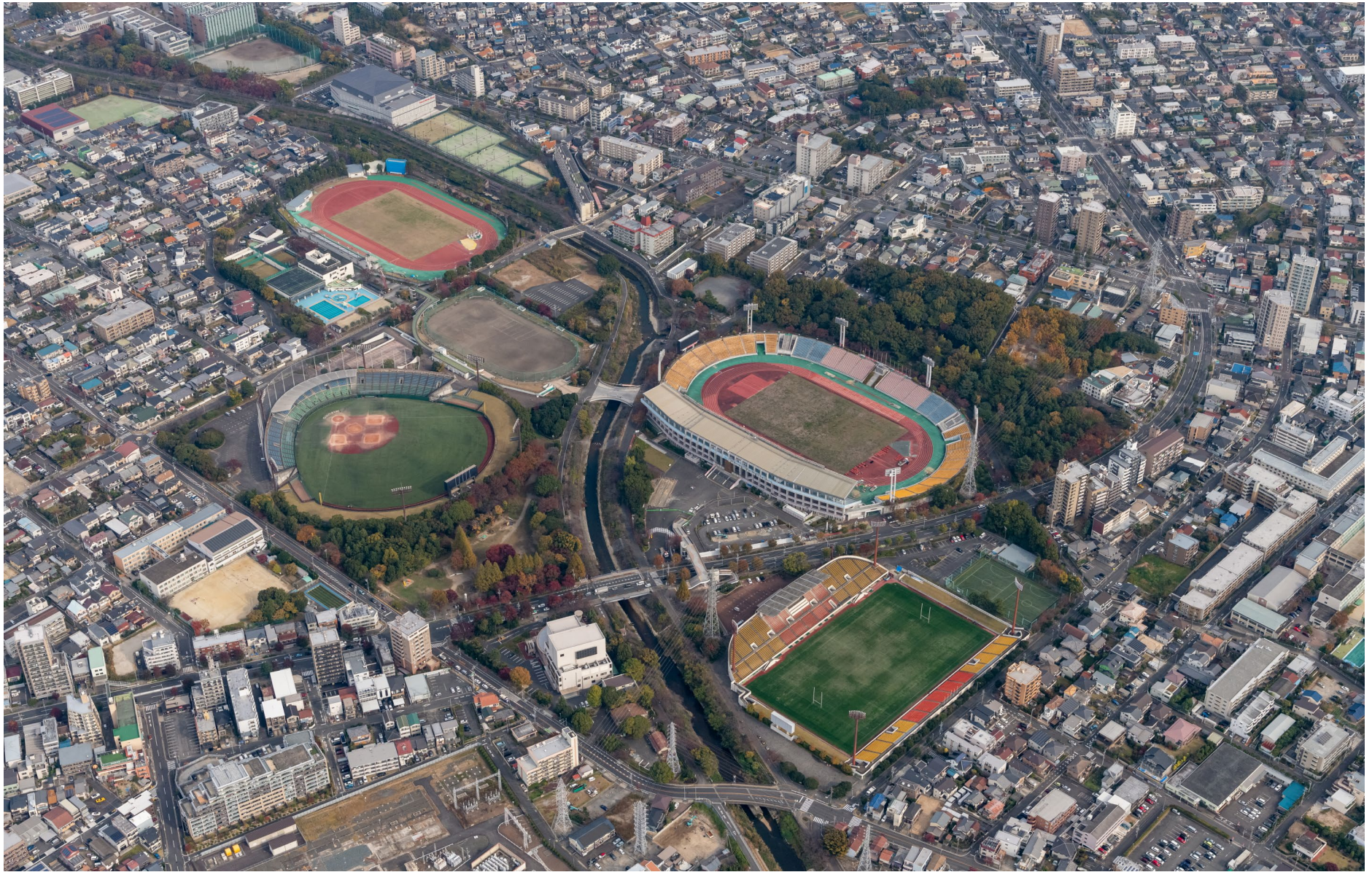
2021.11.19撮影 全景航空写真
