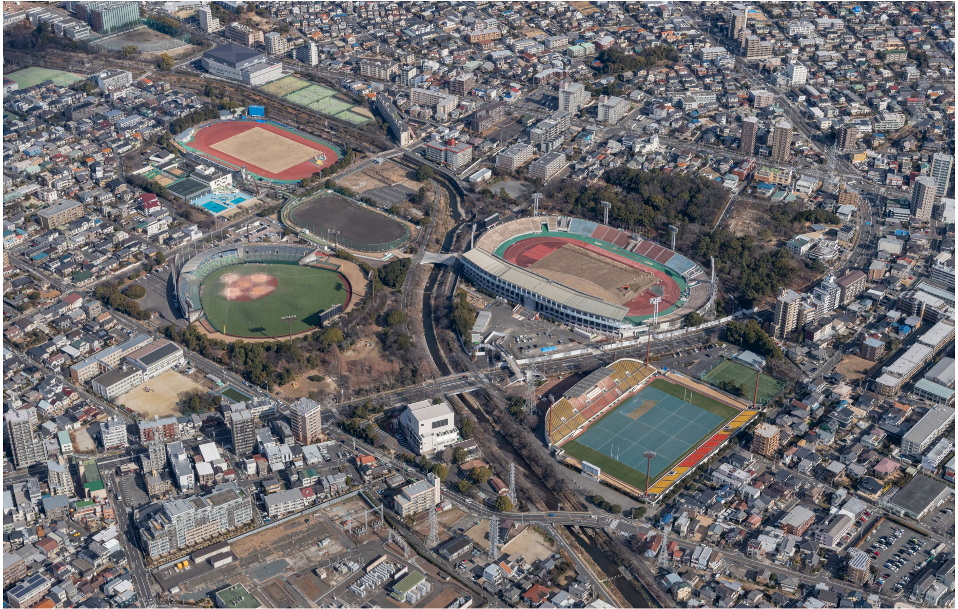
2022.1.21撮影 全景航空写真
