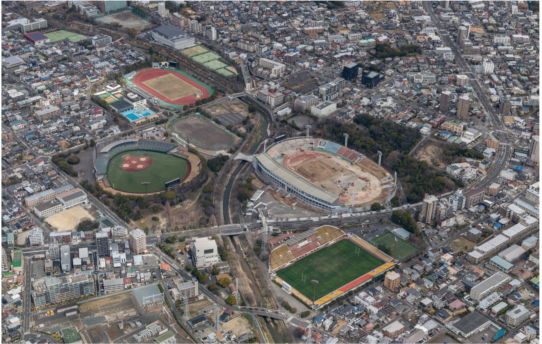
2022.3.20撮影 全景航空写真
