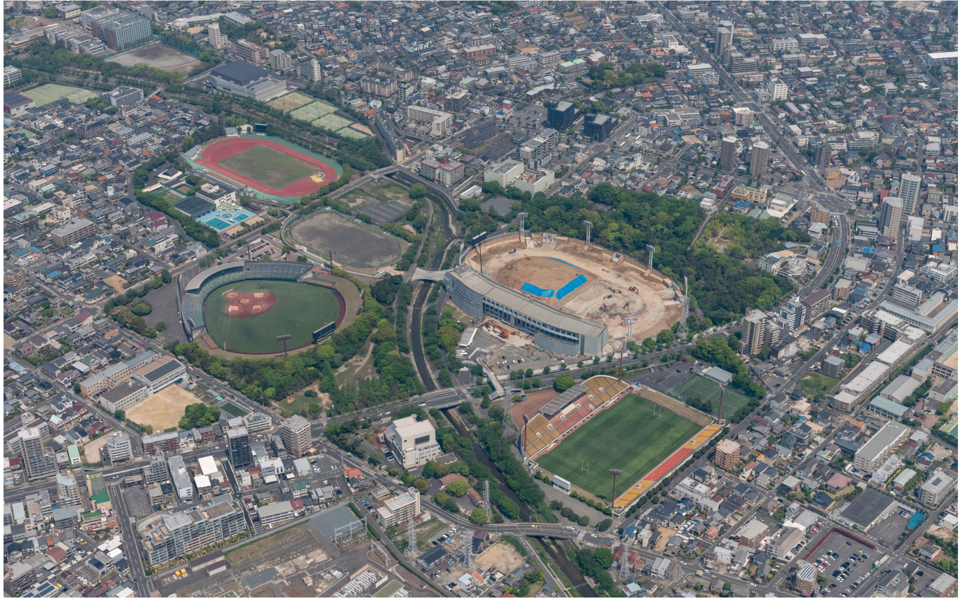
2022.4.20撮影 全景航空写真
