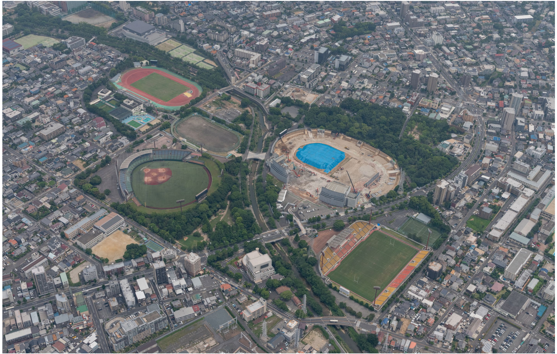
2022.6.20撮影 全景航空写真
