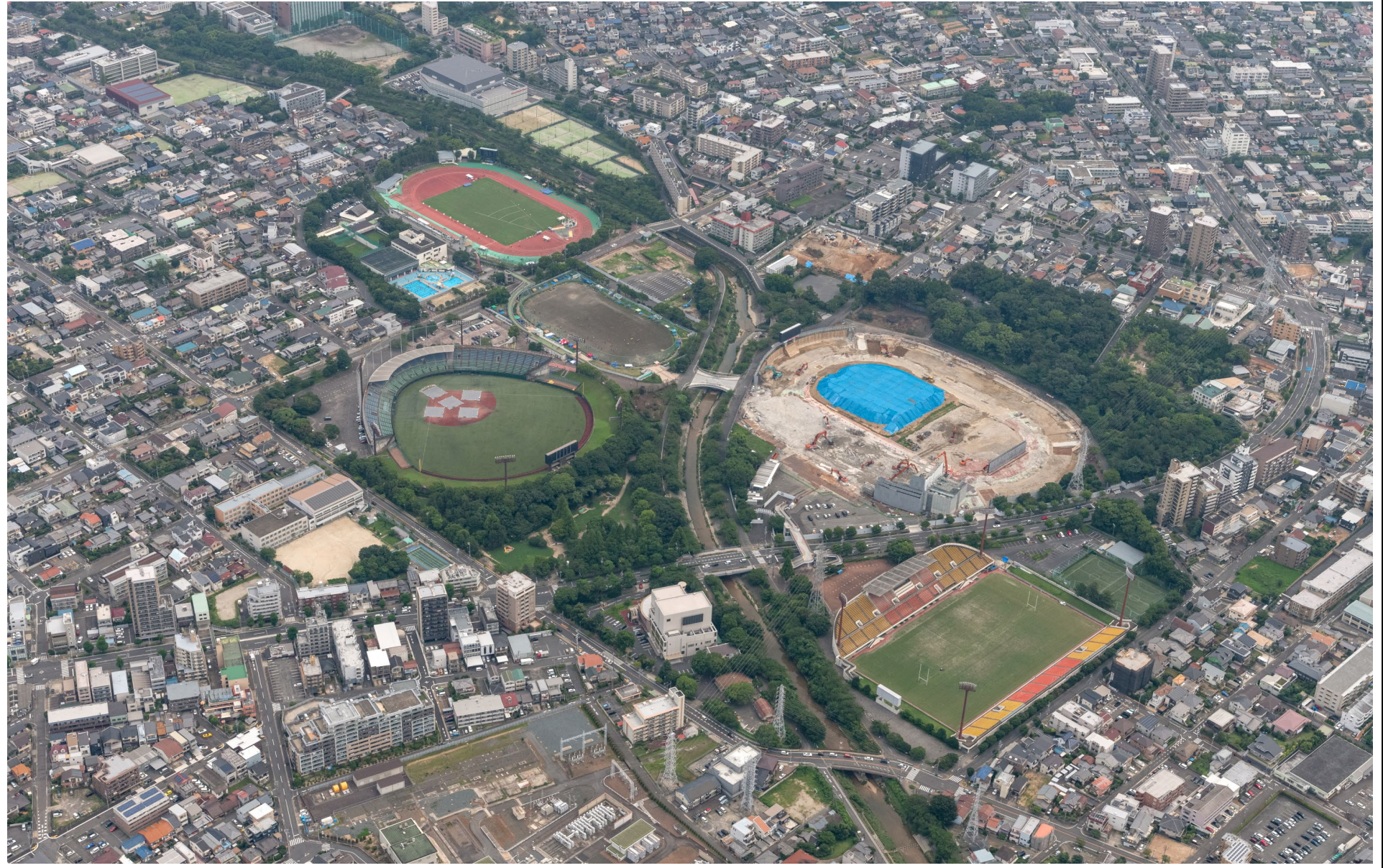
2022.7.21撮影 全景航空写真
