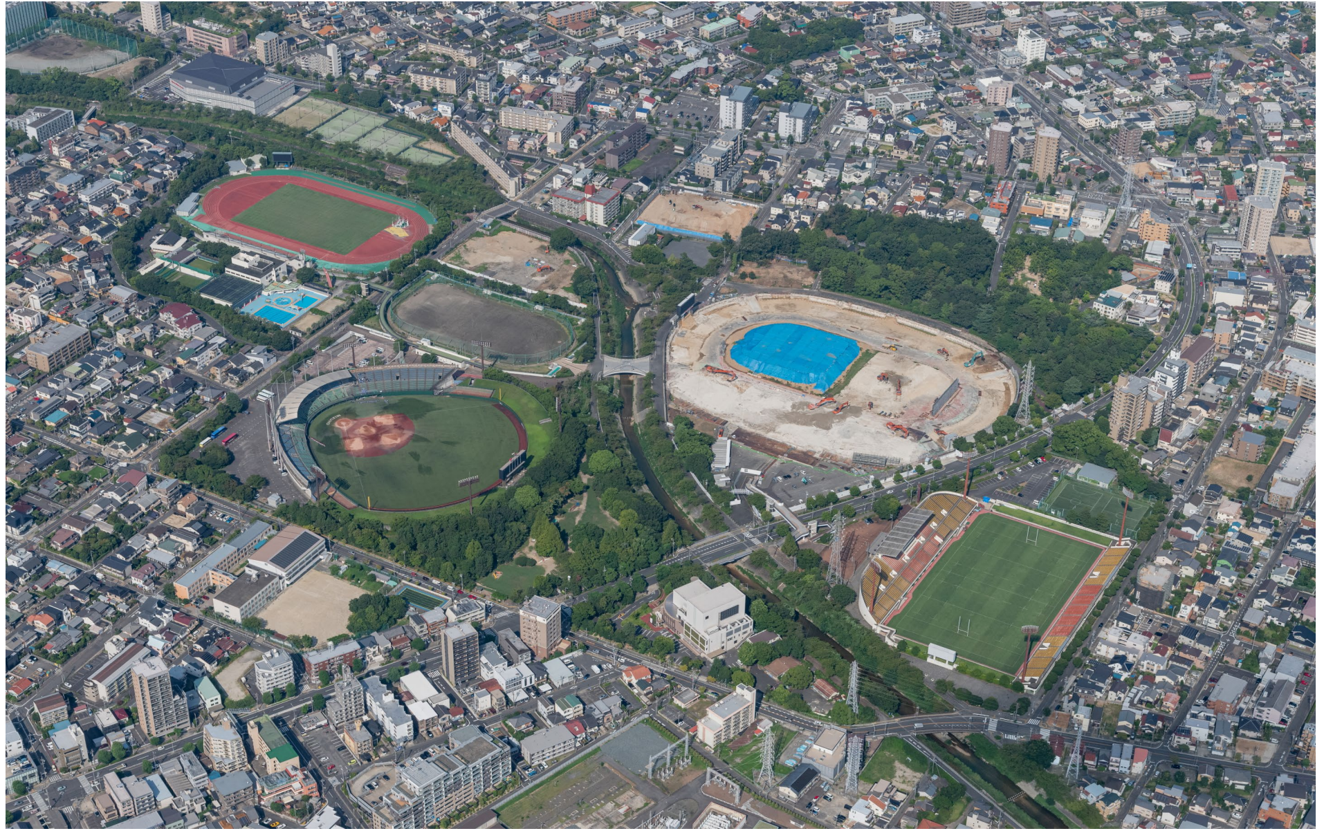
2022.8.22撮影 全景航空写真
