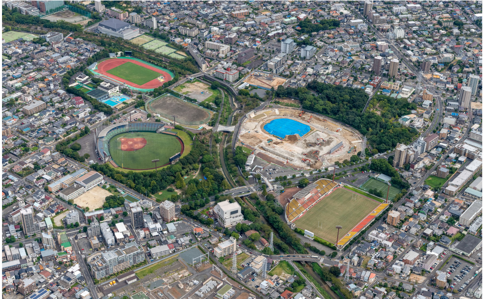
2022.9.21撮影 全景航空写真
