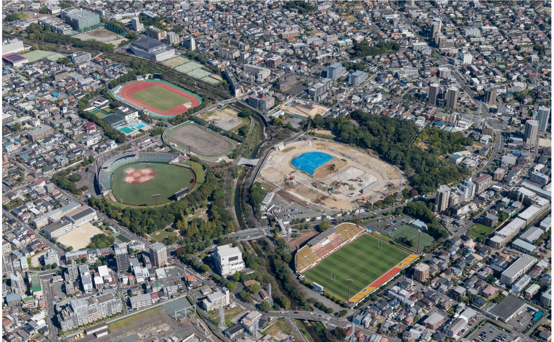
2022.10.20撮影 全景航空写真
