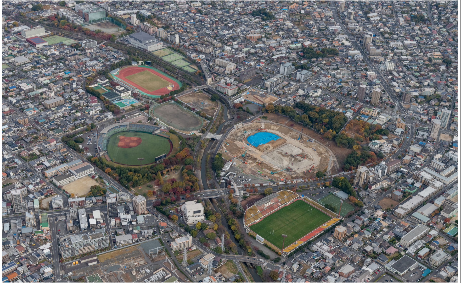
2022.11.22撮影 全景航空写真
