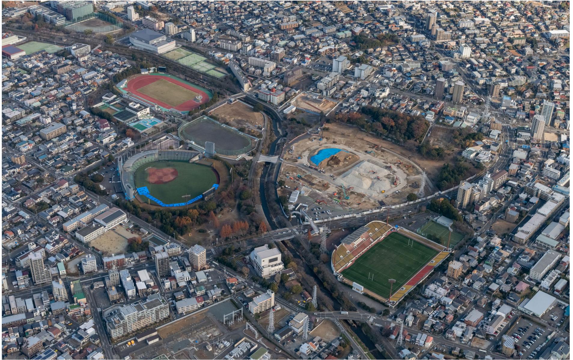
2022.12.19撮影 全景航空写真
