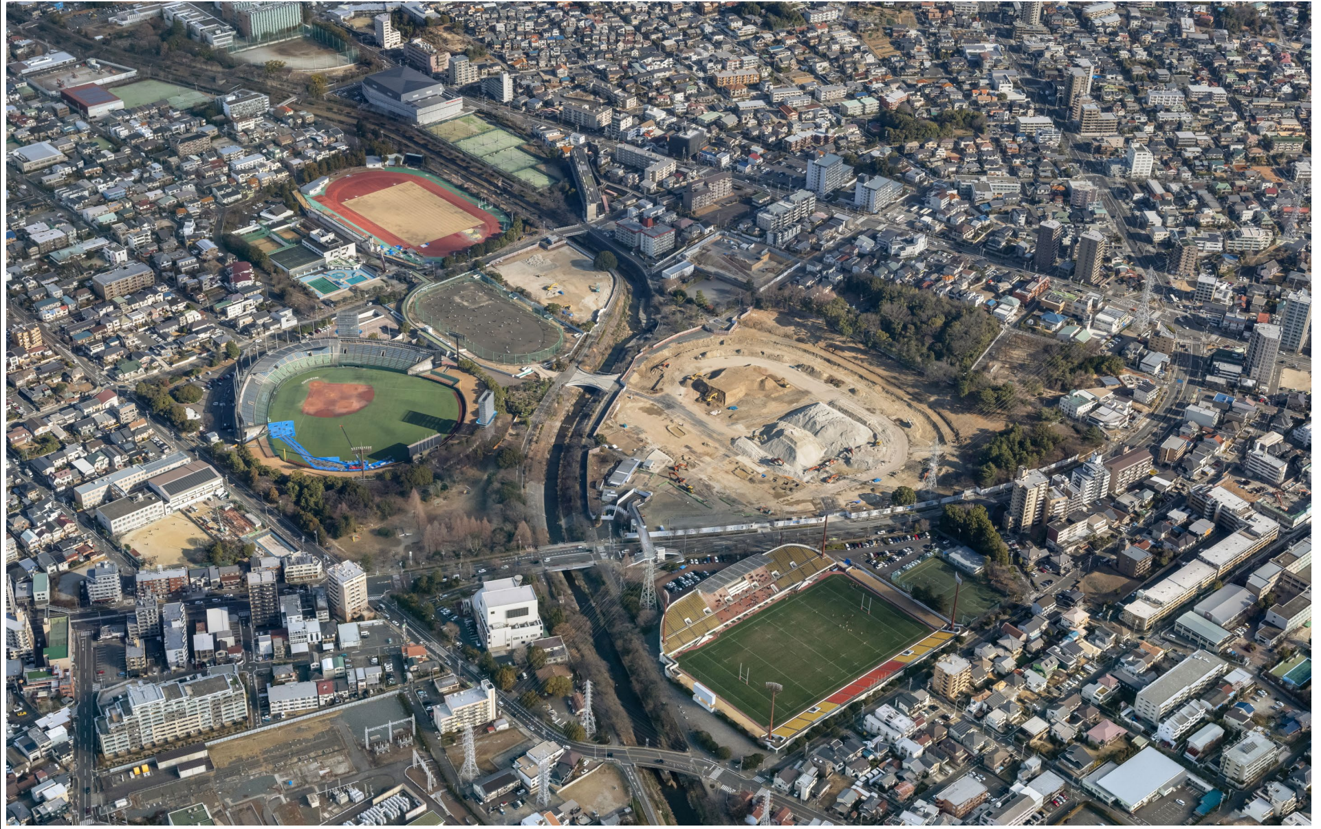
2023.1.21撮影 全景航空写真
