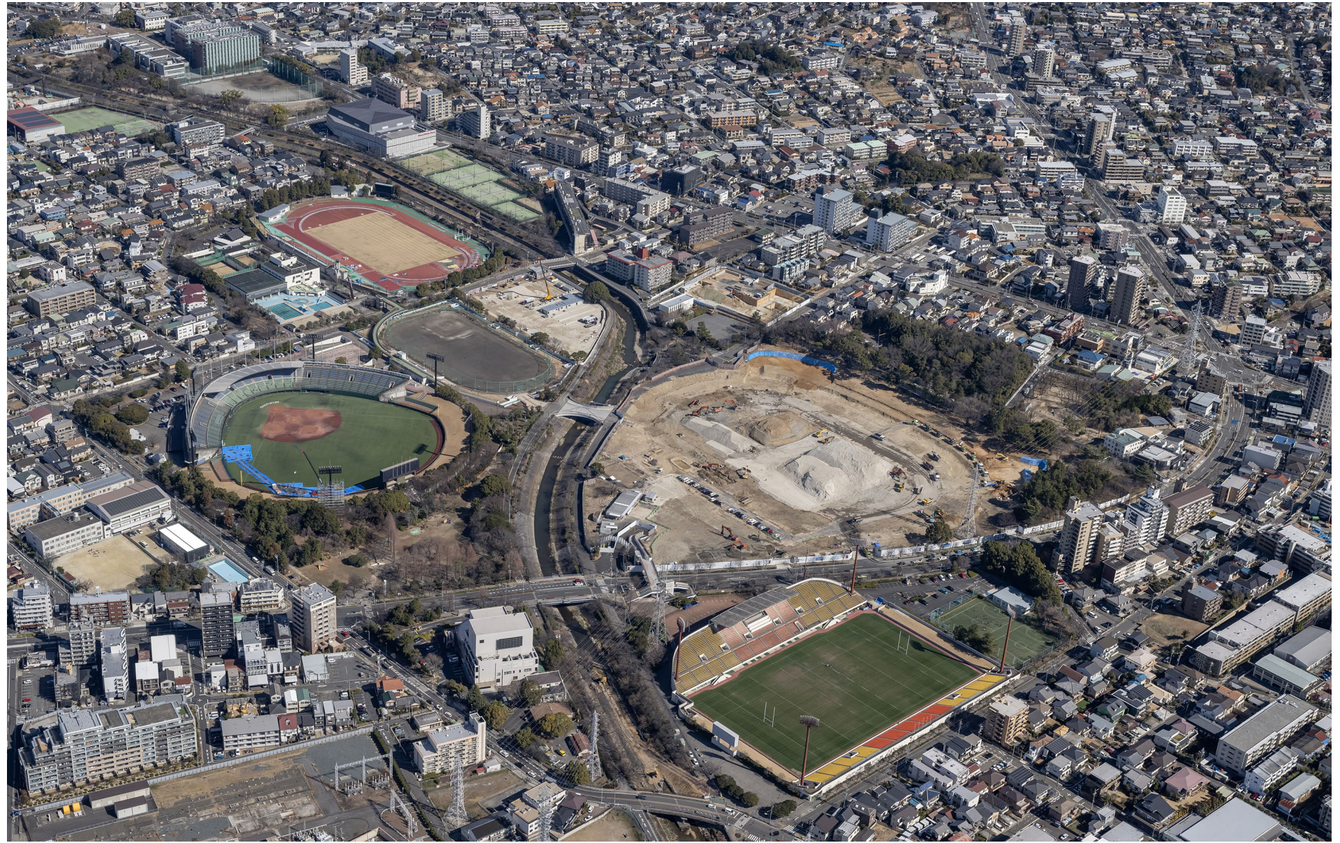
2023.2.21撮影 全景航空写真
