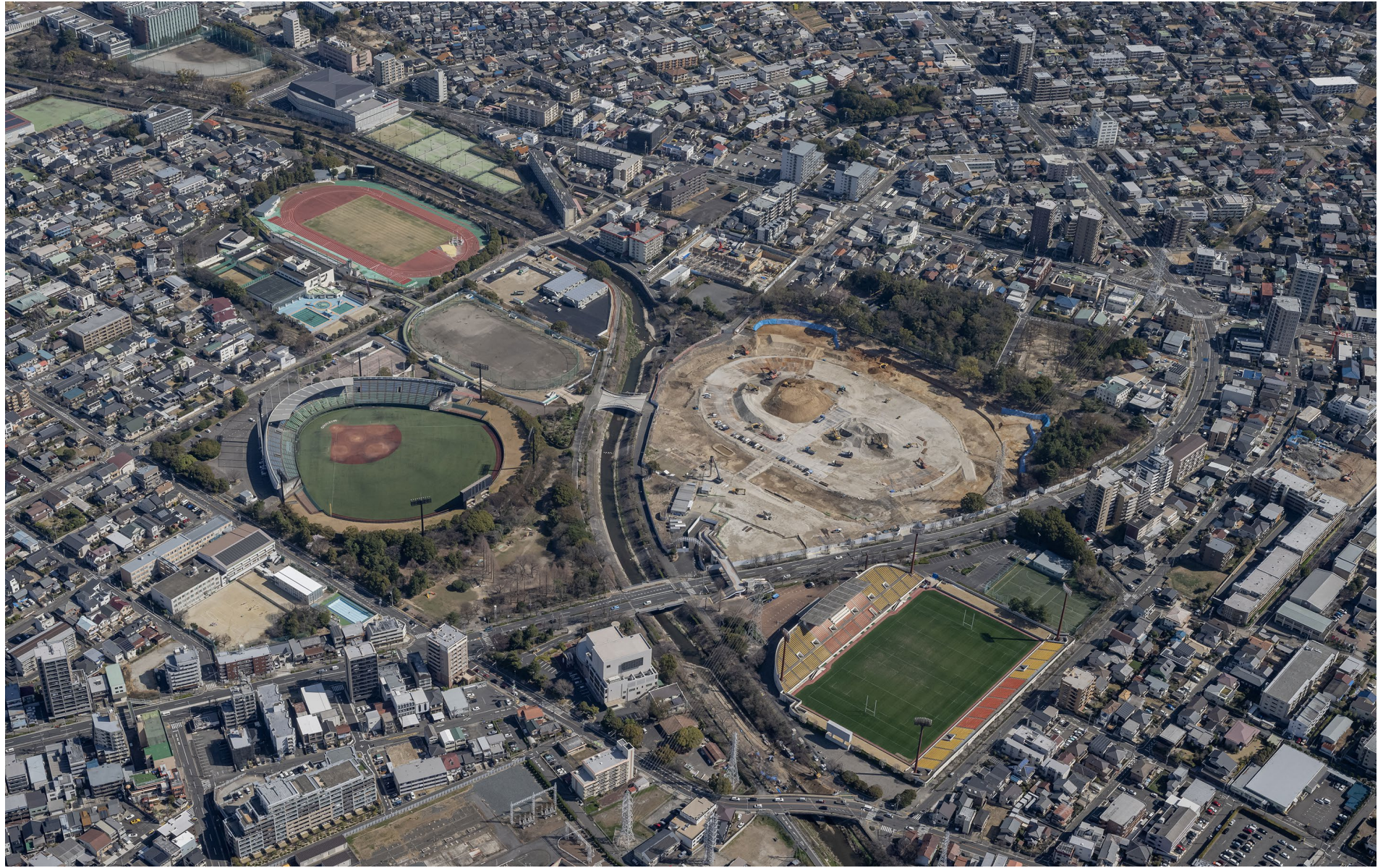
2023.3.20撮影 全景航空写真
