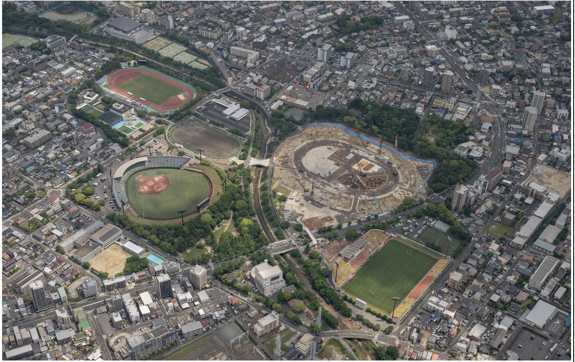
2023.5.21撮影 全景航空写真
