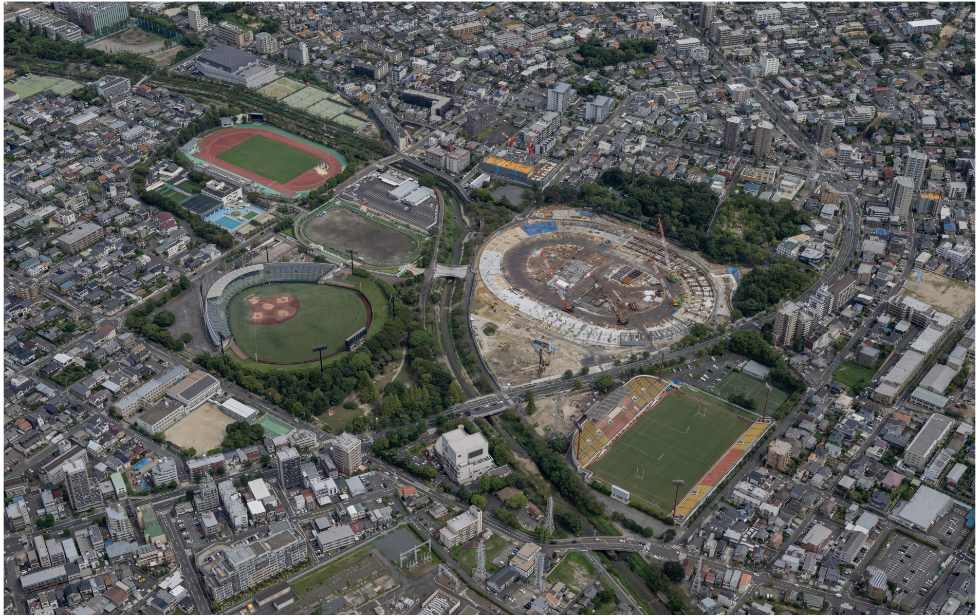
2023.9.23撮影 全景航空写真
