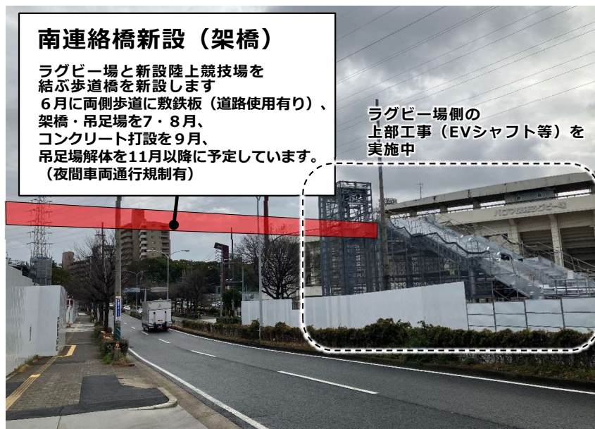
南連絡橋新設 上部工事
