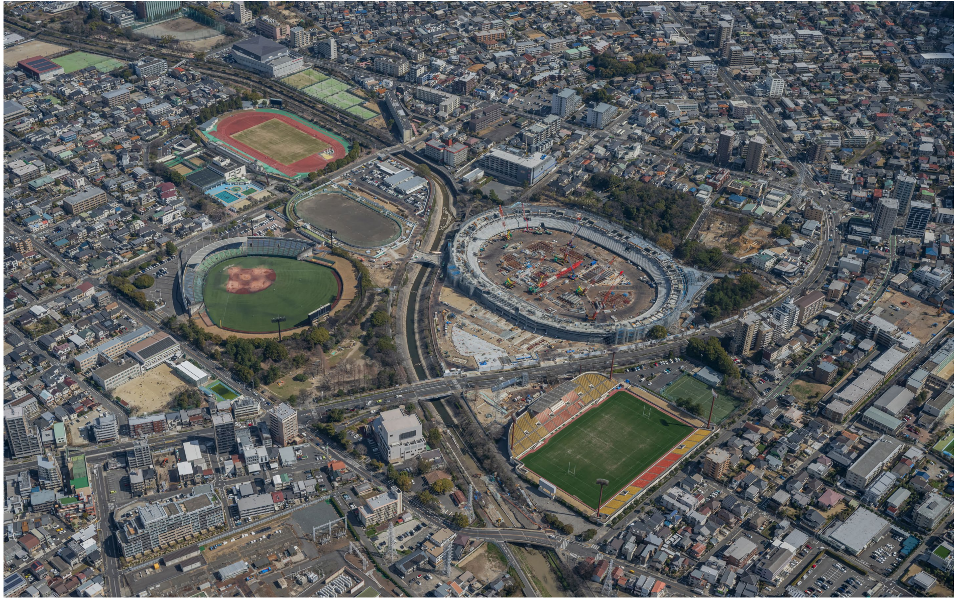
2024.3.21撮影 全景航空写真
