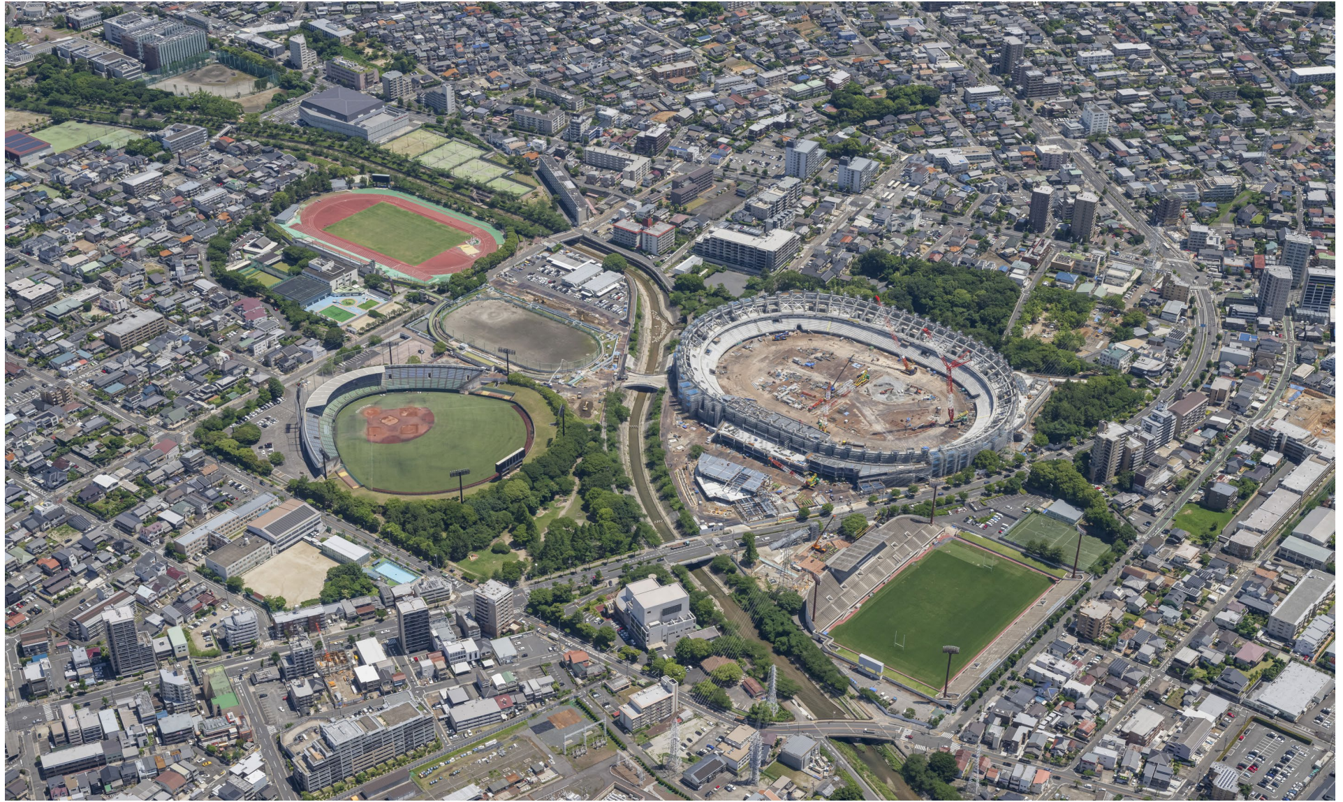
2024.6.19撮影 全景航空写真
