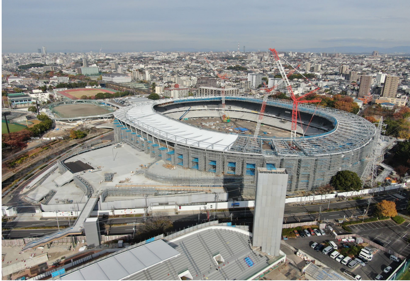
2024.12.13撮影 全景航空写真
