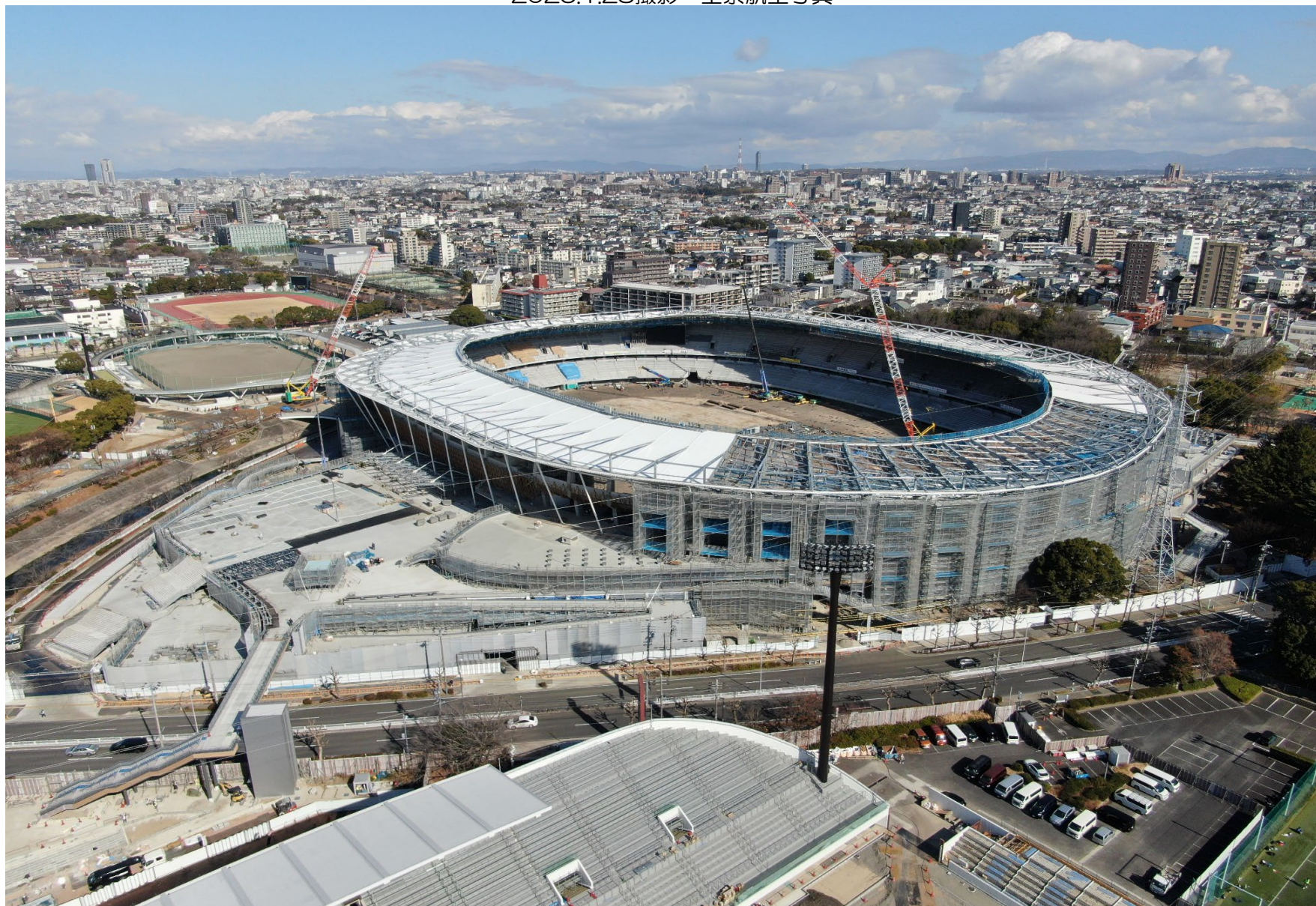
2025.1.28撮影 全景航空写真
