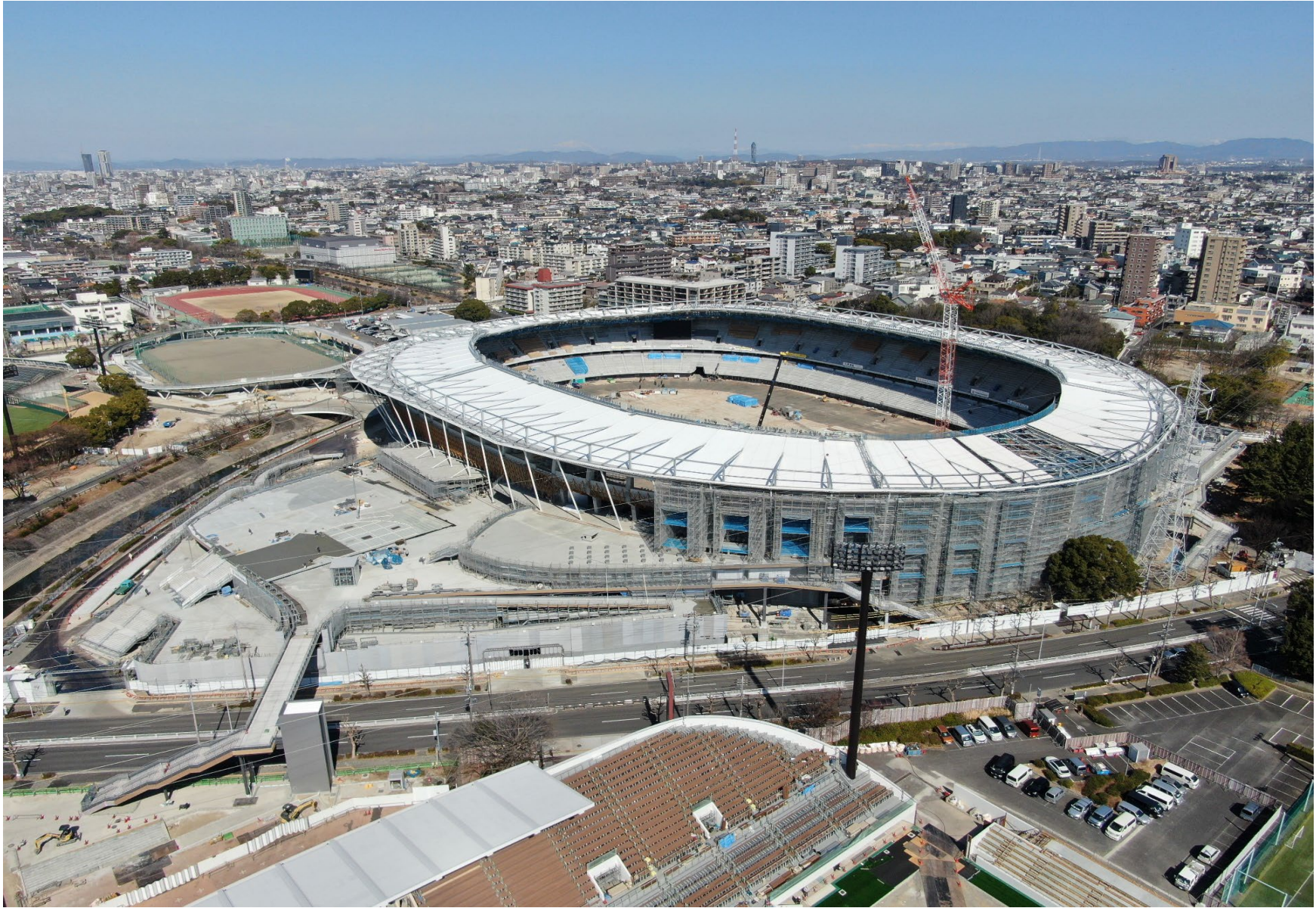
2025.2.25撮影 全景航空写真
