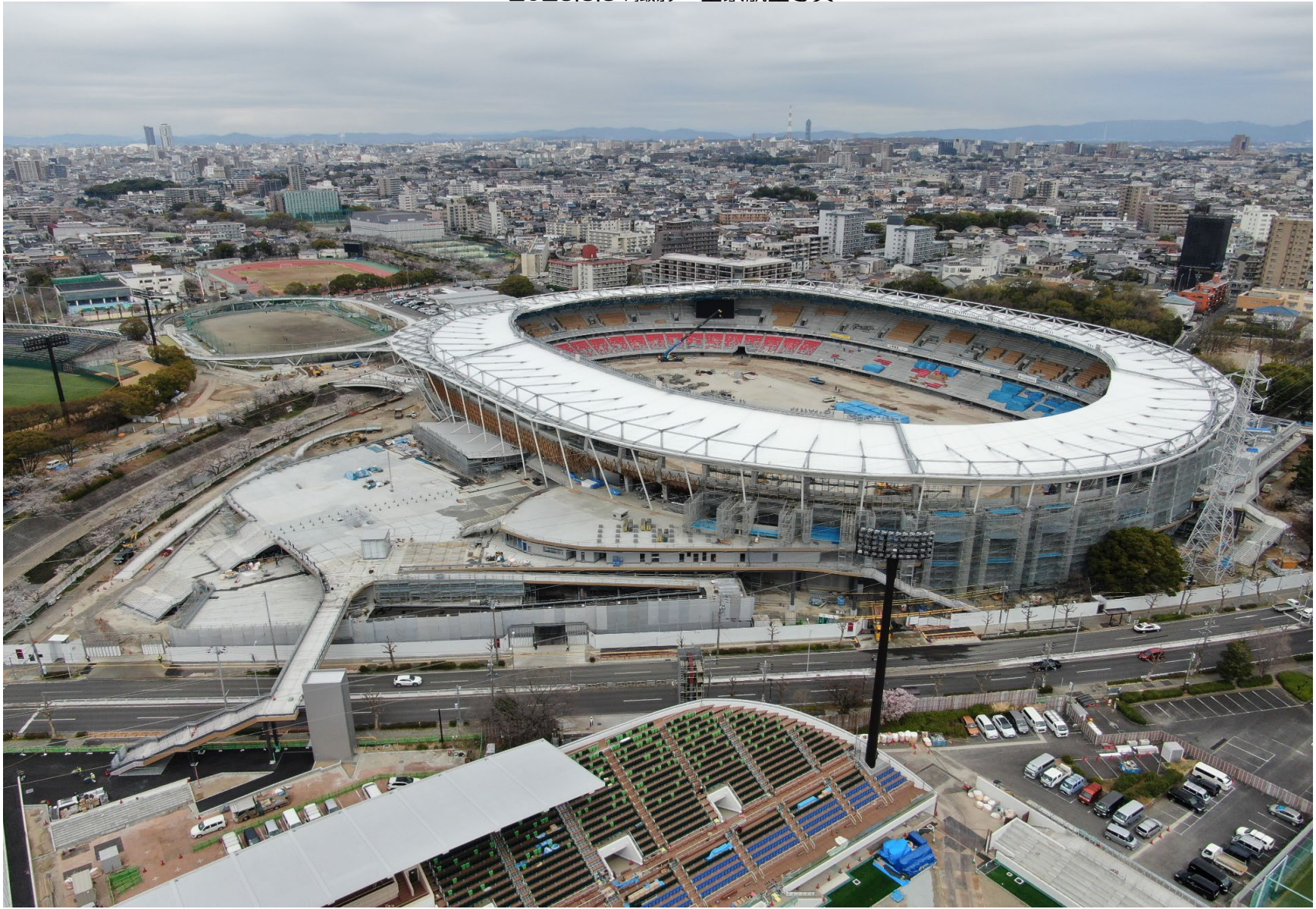
2025.3.31撮影 全景航空写真
