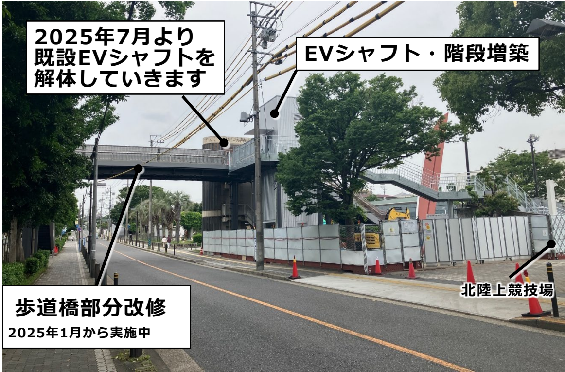
北連絡橋 改修工事（東側より）
