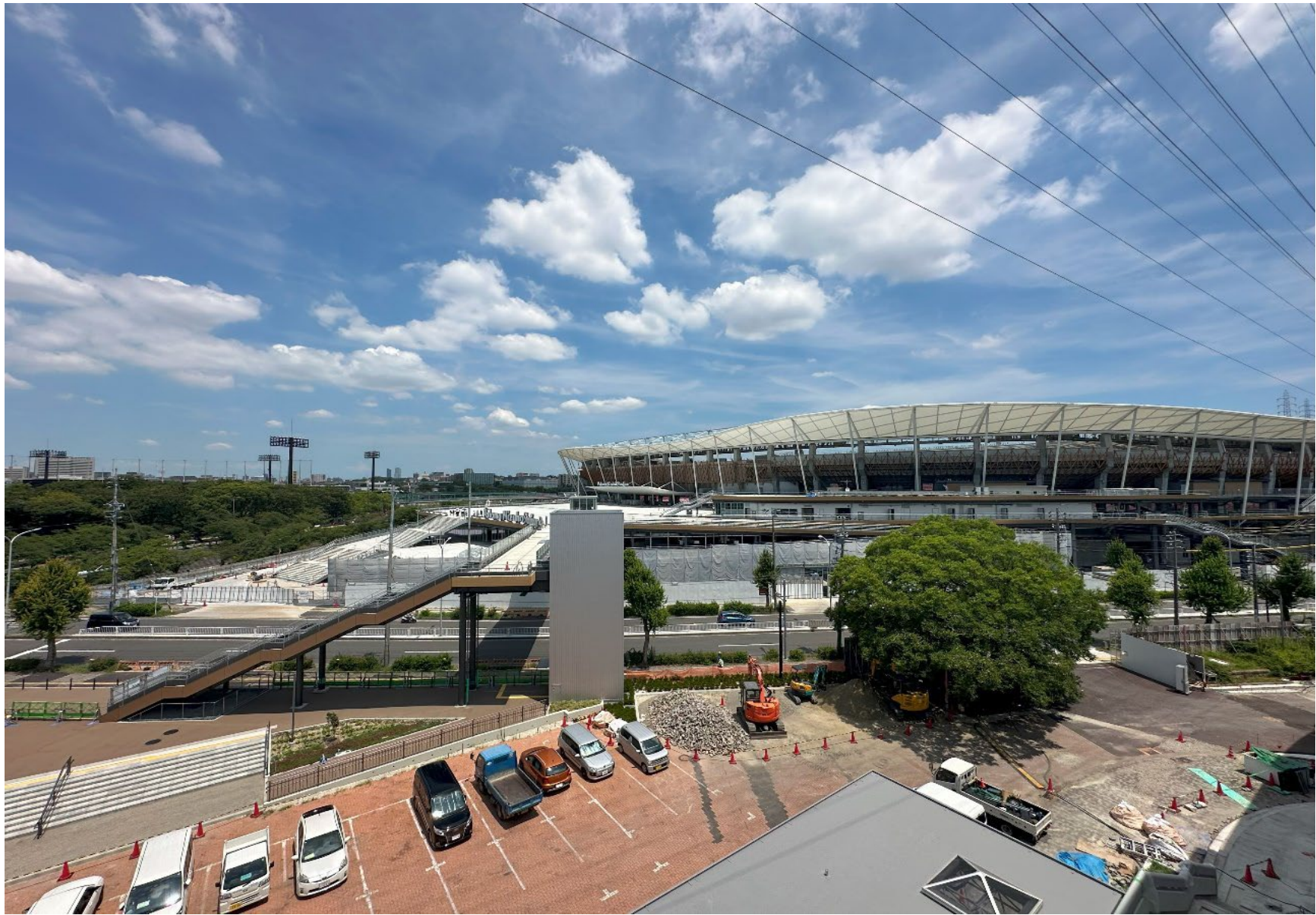
2025.7.28撮影 全景航空写真
